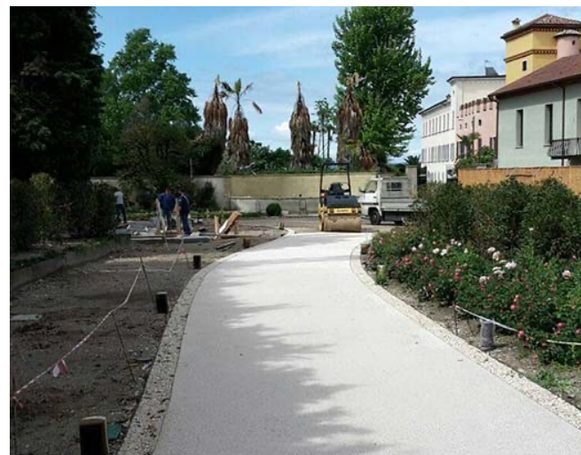
Pavimentazione in calcestre
