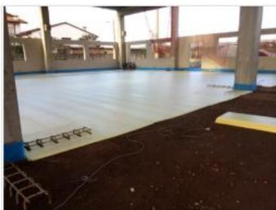
*Posa isolante per impianto di riscaldamento*
