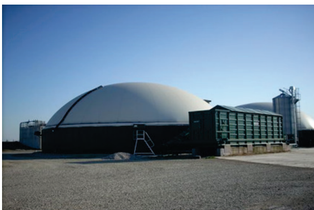
Figura 4 Impianto di digestione anaerobica
